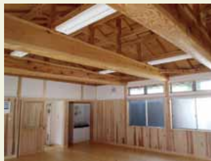
木材加工流通センターの管理棟
